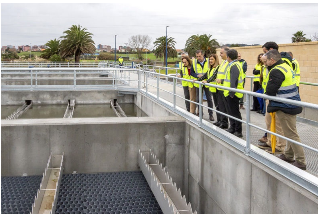
La presidenta junto al consejero de Fomento y el resto de asistentes a la inauguración durante la visita a la depuradora. FOTO: José Cavia
