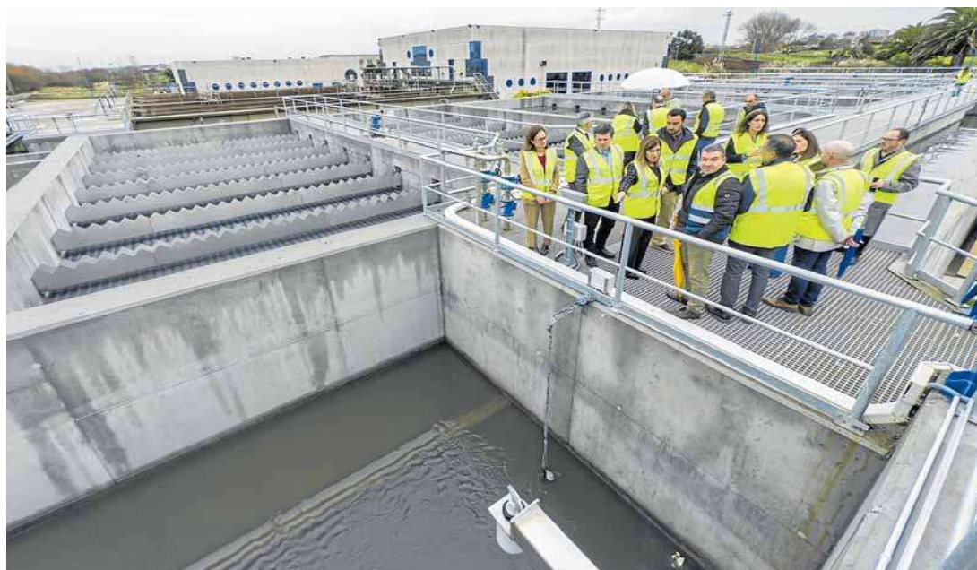
La presidenta de Cantabria, junto a otras autoridades y técnicos, durante la visita a la estación depuradora de San Román. DANIEL PEDRIZA
